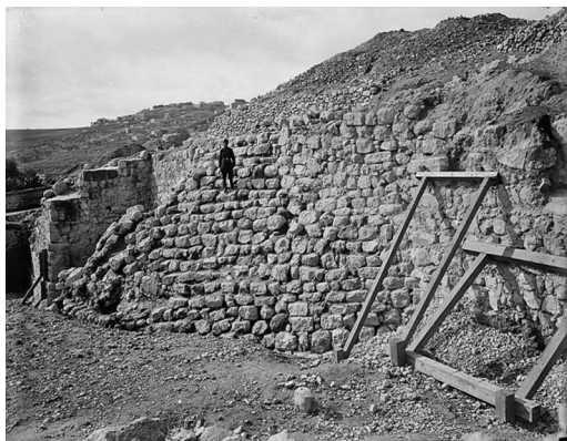
Zidul lui Neemia, construit la Ierusalim
